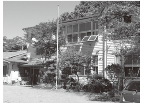
廃校になった小学校にある牧郷ラボ 窓辺にも太陽光パネルを設置
